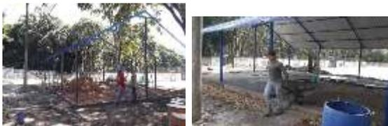
Se realizó mantenimiento cubierta de kiosco antiguo, desmonte del techo y nueva cubierta, pintura de la estructura metálica.
